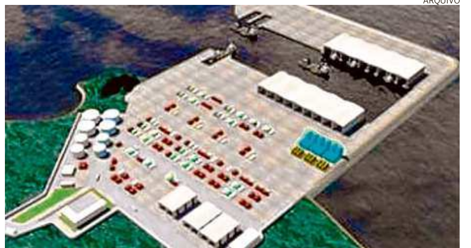
C-Port Brasil será instalado próximo à Área de Proteção Ambiental de Guanandy
