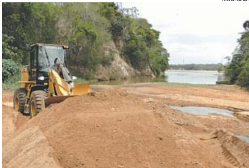
OBRA de expansão da barragem vai evitar que lama chegue ao Rio Pequeno
