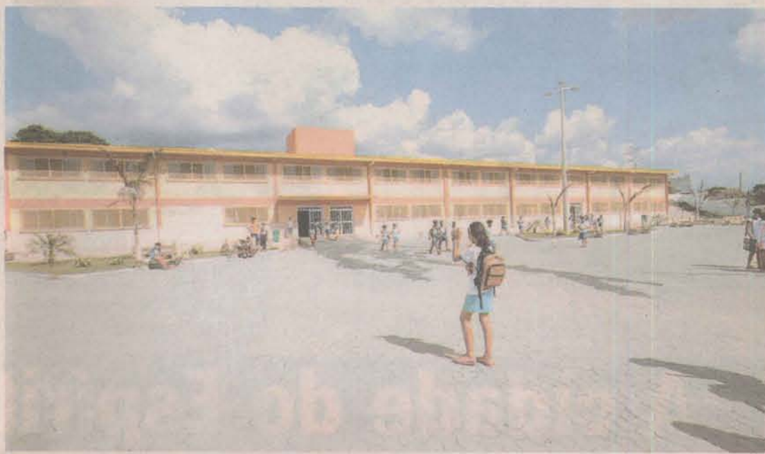
Uma das marcas da atual administração é o investimento na construção, reforma e reaparelhamento das escolas
