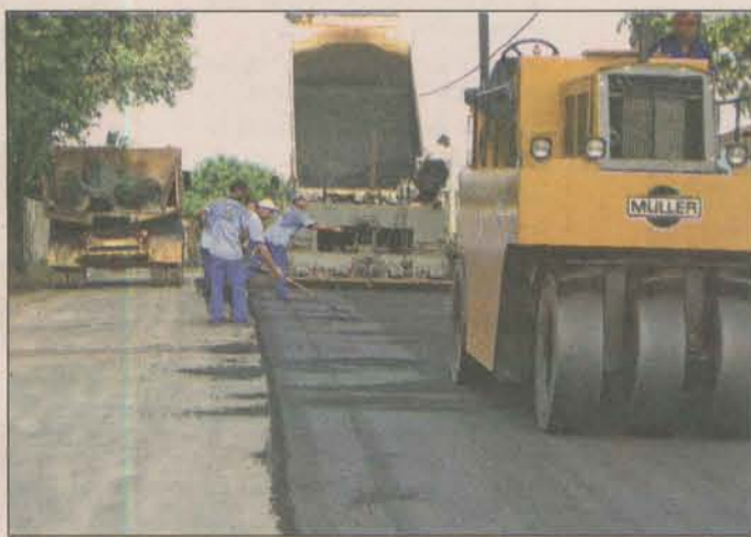
Pista recebe pavimentação: desenvolvimento
