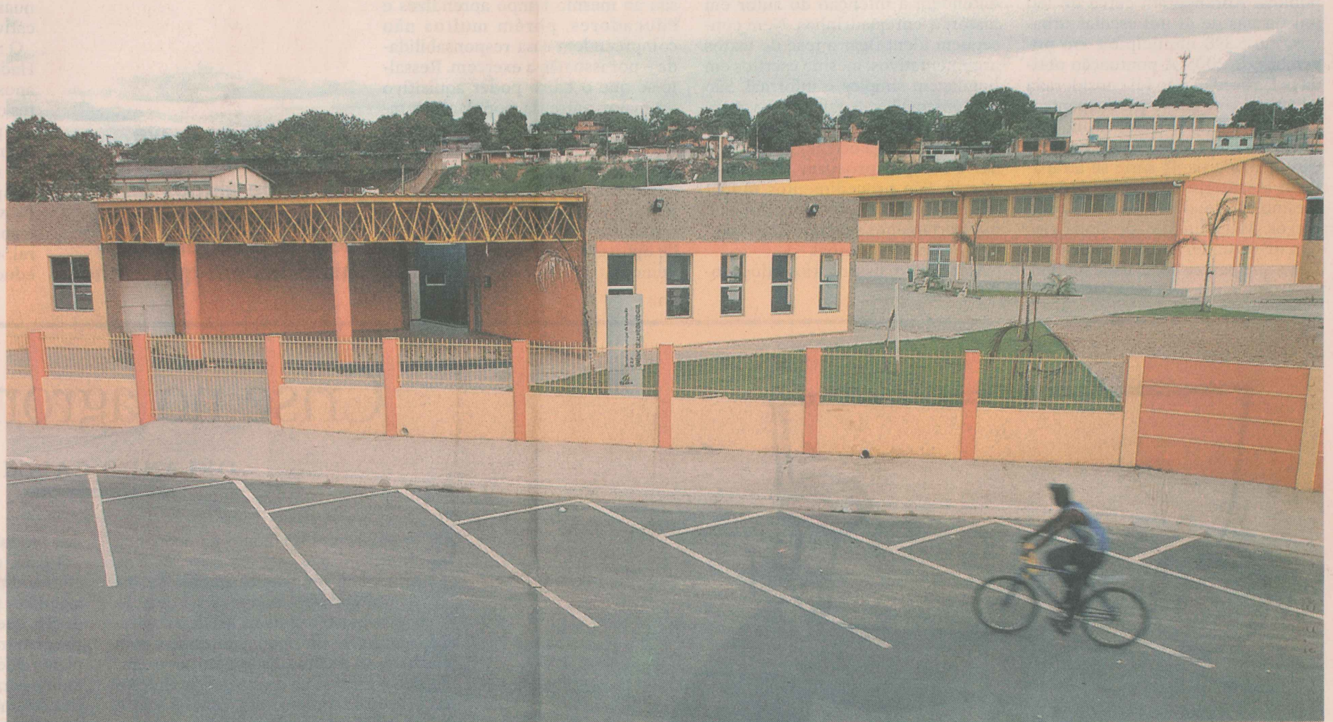
EDUCAÇÃO. A Serra, que em 2005 teve orçamento de R$ 341,8 milhões, investiu R$ 13 milhões em reforma e construção de escolas. FOTOS: FÁBIO VICENTINI
