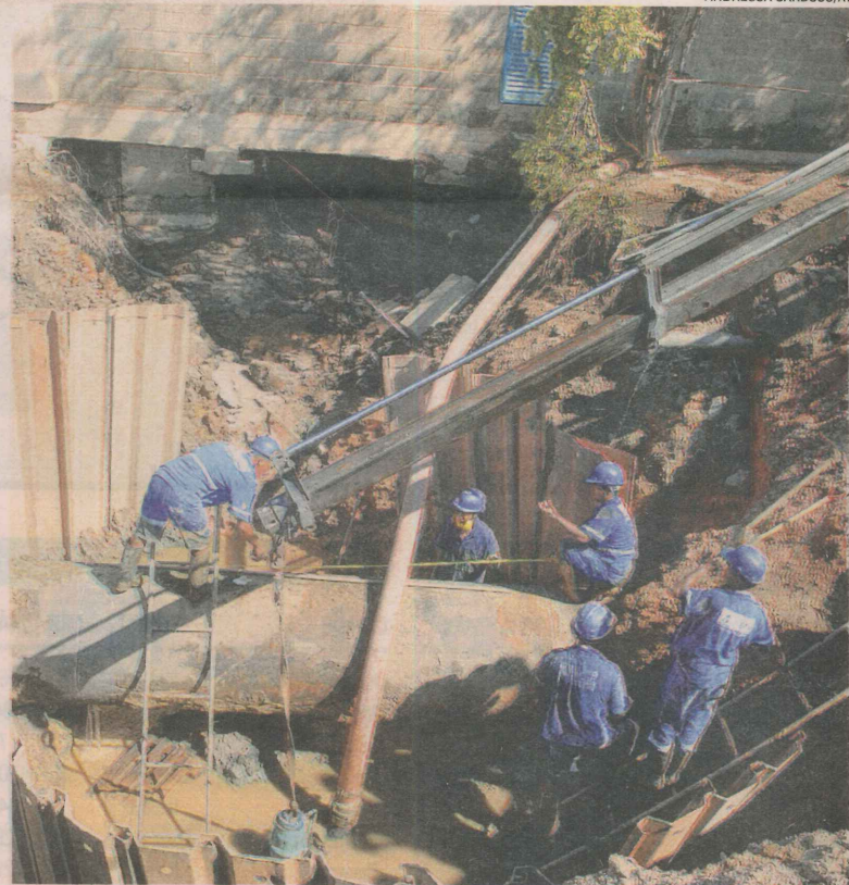
FUNCIÓNÁRIOS trabalham no reparo da adutora, que fica em Cobilândia
