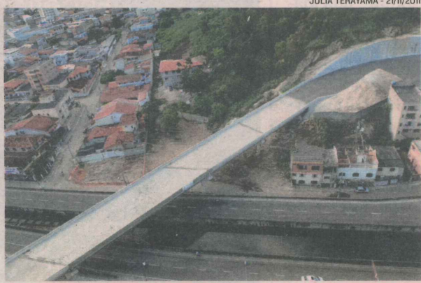
VIADUTO DA TERCEIRA PONTE aumentou em 200 metros e vai até a rua Resplendor, em Itapoã
