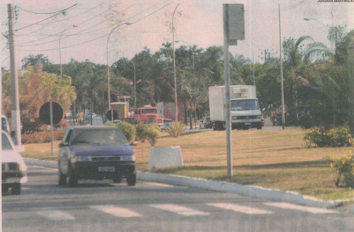
TRECHO DA BR-101 que terá intervenções para reduzir os engarrafamentos. Obras começam em abril
