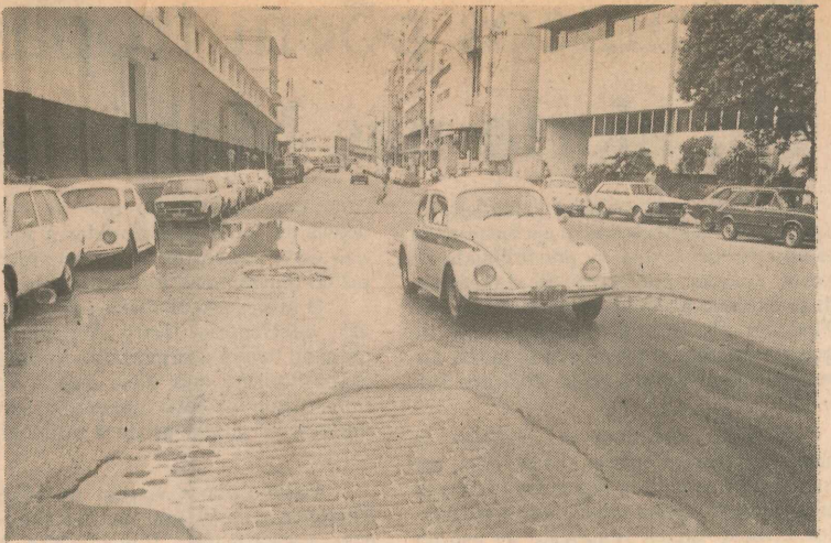
Falta de manutenção na avenida Getúlio Vargas
