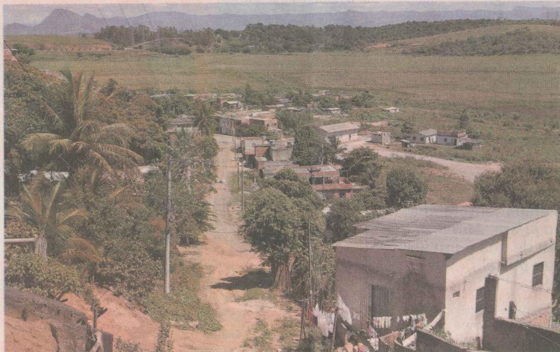
INFRA-ESTRUTURA. Maioria das vias de Solar de Anchieta ainda não conta com pavimentação
