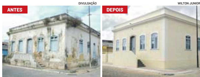
CONSTRUÍDO em 1876, o casarão foi restaurado. Inauguração será dia 13
