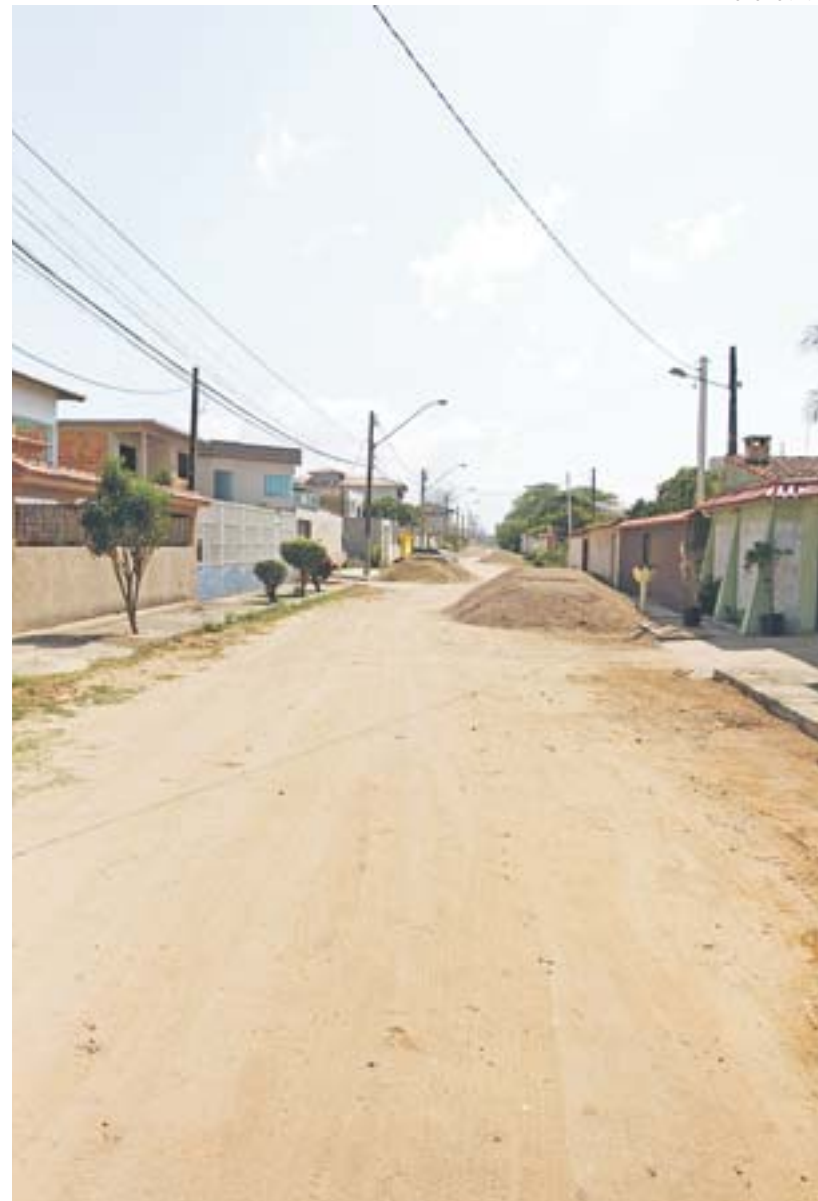
RUA Altair Rocha Costa que precisa de serviços de infraestrutura
