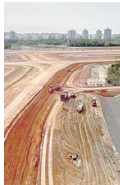
SERVIÇOS de terraplanagem
