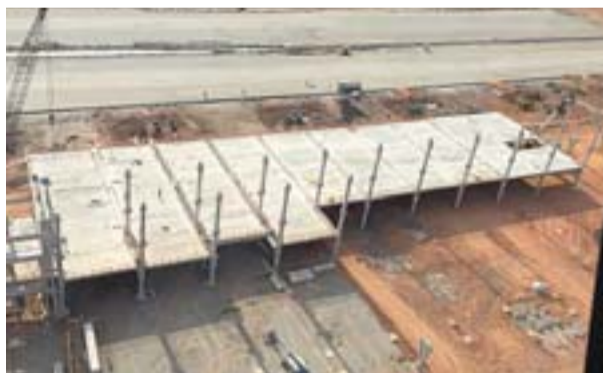
LAJES E PILARES do terminal de passageiros
