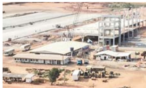
ESTRUTURA montada para construções no aeroporto
