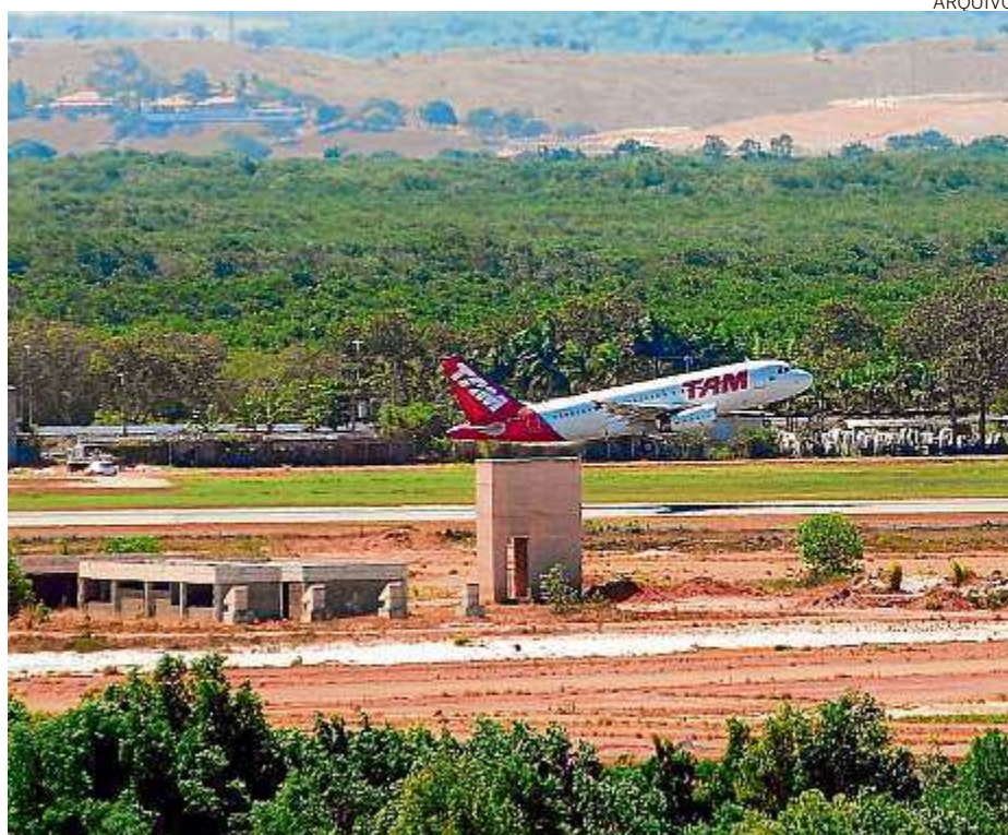
Obras de reforma e ampliação do Aeroporto de Vitória estão paradas desde 2008
