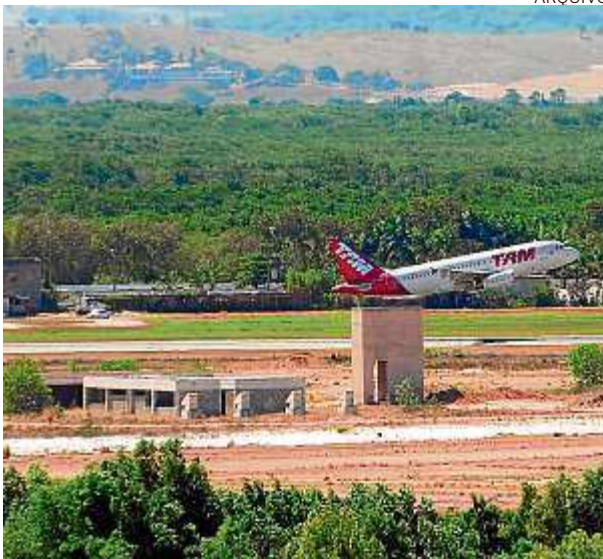
Obras de reforma do terminal se arrastam desde 2005
