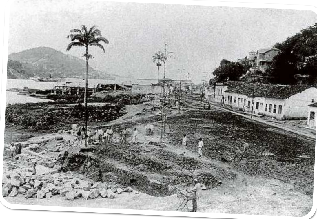
Foto antiga mostra o início do aterro no que seria mais tarde a Avenida Jerônimo Monteiro, no Centro. FOTO: ACERVO JOSÉ TATAGIBA
