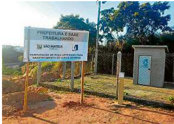
Dois poços artesianos foram perfurados em São Mateus
