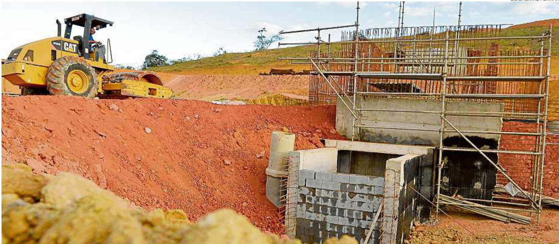
Em plena construção, Sistema de Abastecimento de Reis Magos terá estação de tratamento, reservatório de água tratada e adutora de água bruta e tratada
