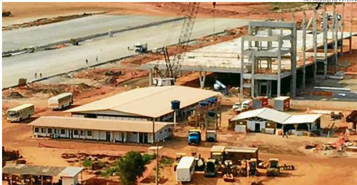
Canteiro de obras: lajes pré-moldadas já começam a dar cara ao novo terminal de passageiros
