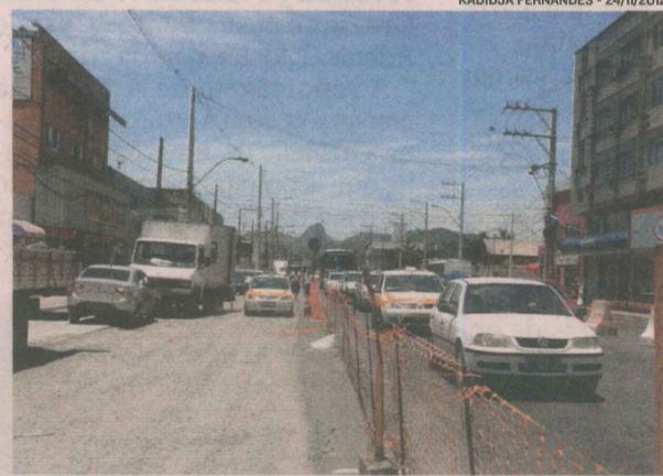
AS OBRAS DA AVENIDA Fernando Ferrari estão na última etapa. A ampliação deve ser concluída até o final deste mês
