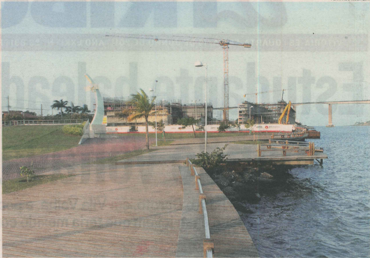
PIER na Praça do Papa onde será construída uma estação do aquaviário: intenção é melhorar a mobilidade urbana
