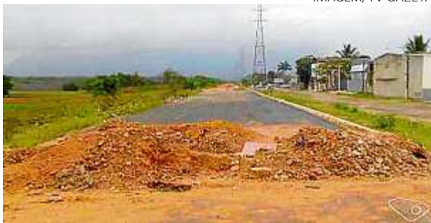
Via em Jardim Carapina está abandonada desde 2014
