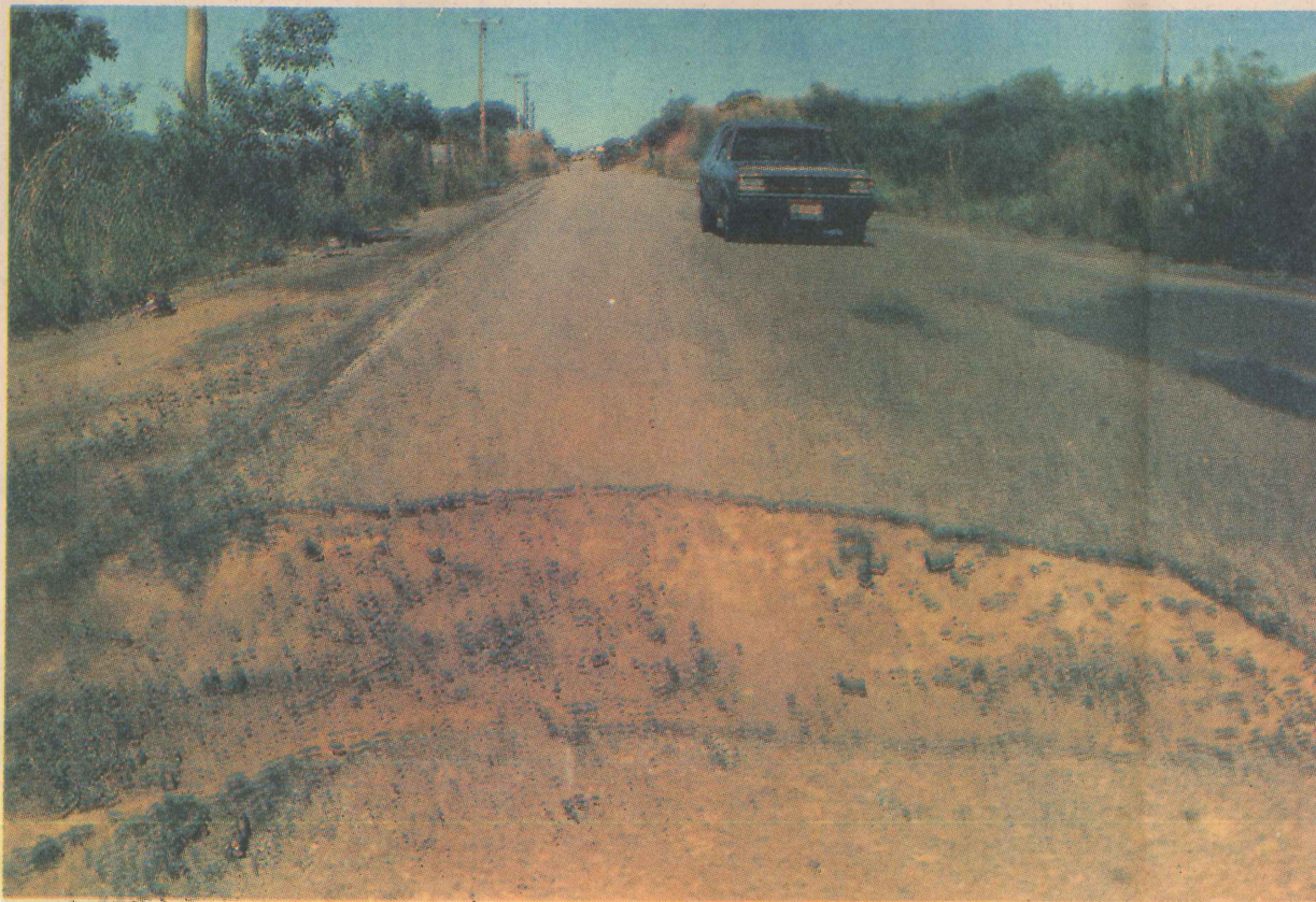
As obras de reforma da principal via de acesso aos balneários serranos já foram iniciadas pelo DER-ES
