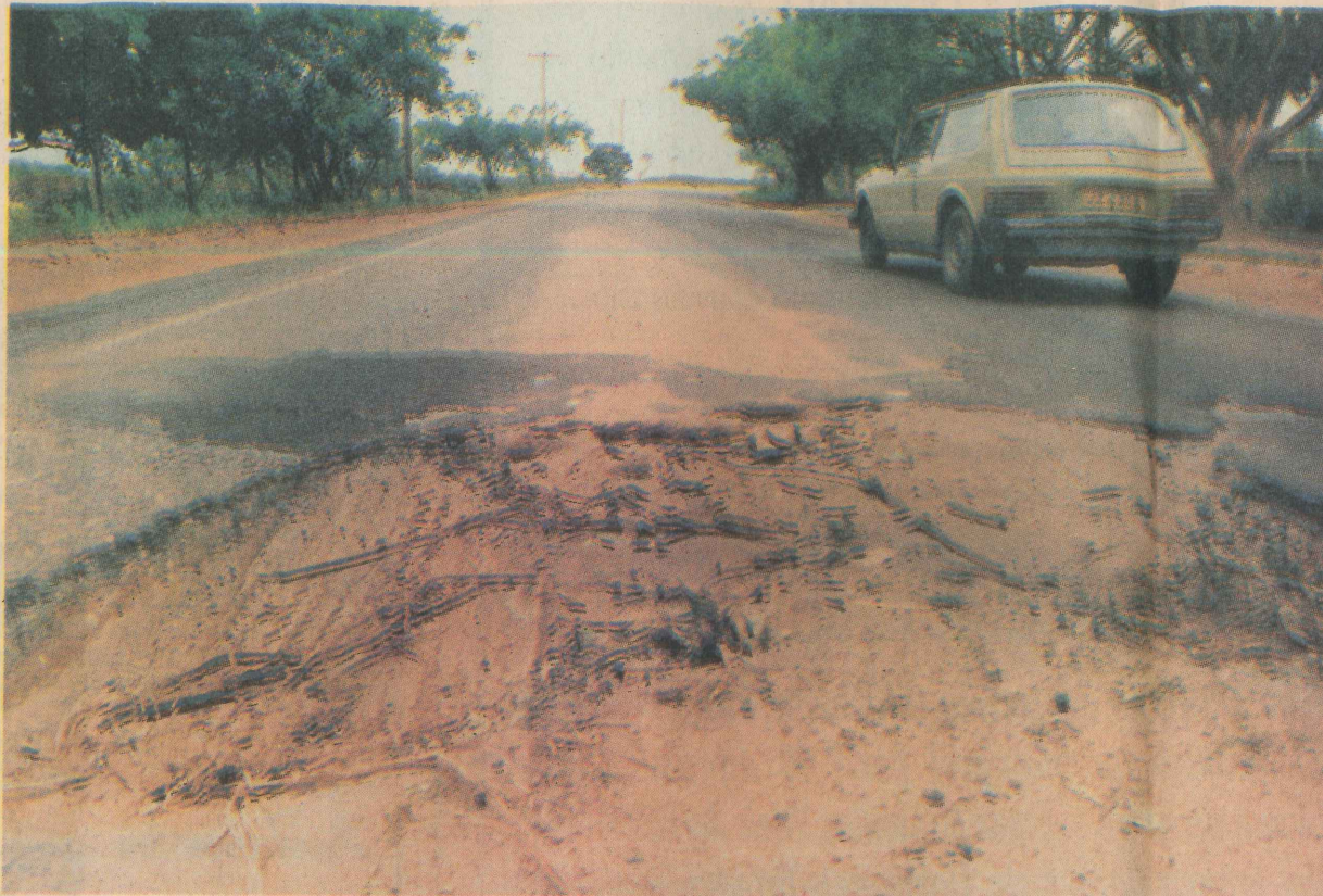
Com muitos buracos na pista, os motoristas devem ter cuidado redobrado para evitar acidentes fatais
