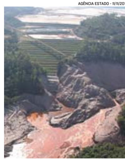
BARRAGEM de Fundão rompeu
