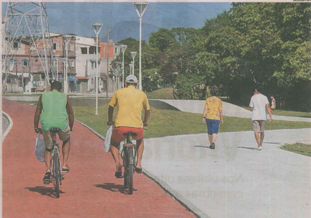
NA ORLA DE MARIA ORTIZ, foram construídas quadras, parques e um calçadão de 976 metros com ciclovia
