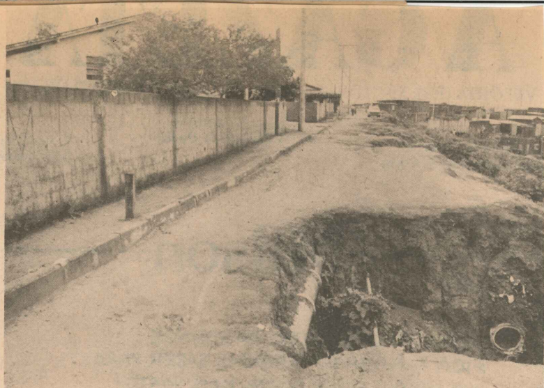
A erosão está destruindo as ruas do conjunto José de Anchieta.
