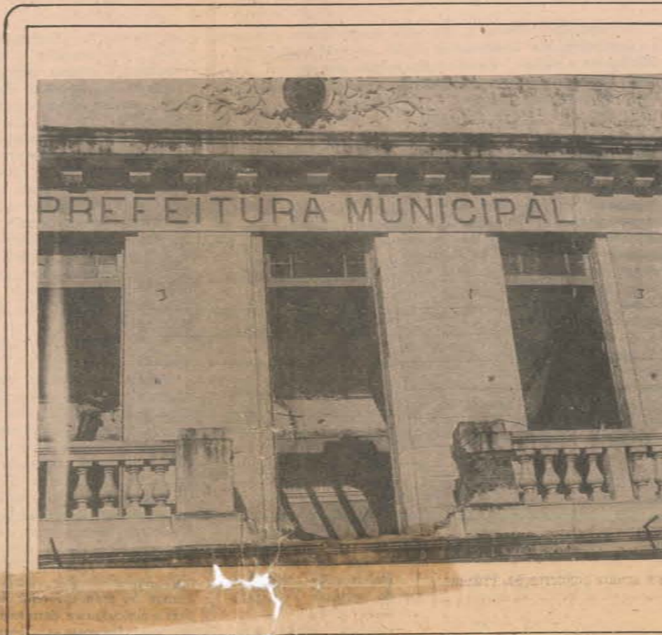
Por aqui passaram a maioria dos prefeitos. O prédio foi demolido no Governo de Crisógono Teixeira da Cruz
