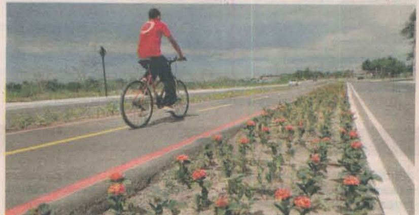
CICLOVIA foi um dos pontos das obras de revitalização no Cívico
