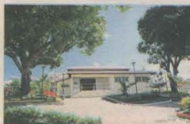
CENTRO DE VIVÊNCIA: obra
