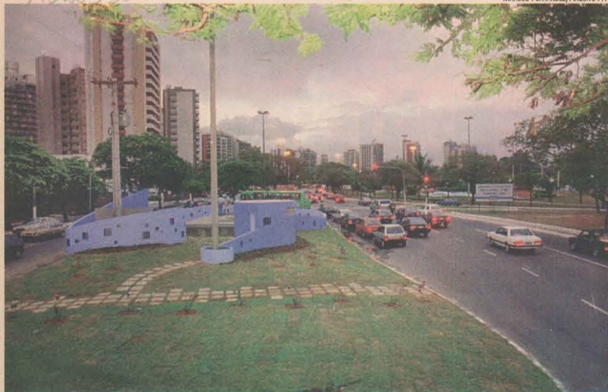
A estação de bombeamento da Praia do Canto foi inaugurada em setembro
