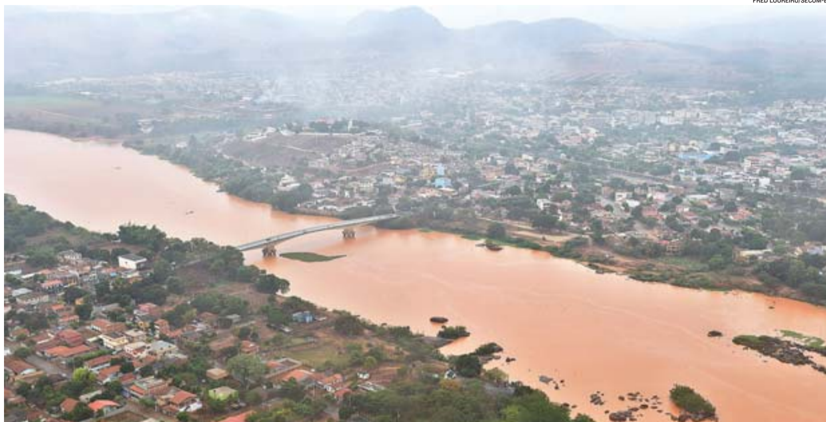
LAMA NO RIO DOCE, na cidade de Baixo Guandu, depois do rompimento da barragem da mineradora, que causou o maior desastre socioambiental do País
