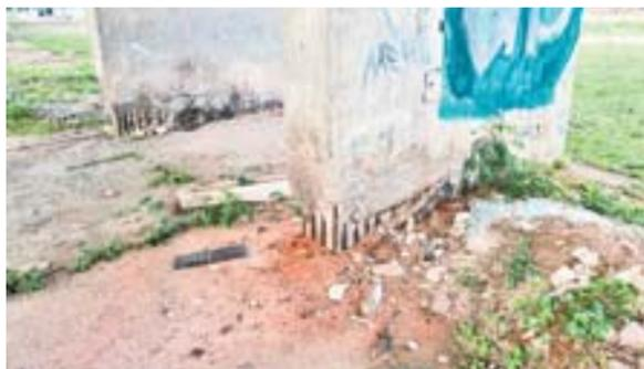
**A SUJEIRA** e as pichações tomam conta e deterioram as colunas de sustentação da ponte, que já estão sem o concreto e com as vigas metálicas visíveis.
