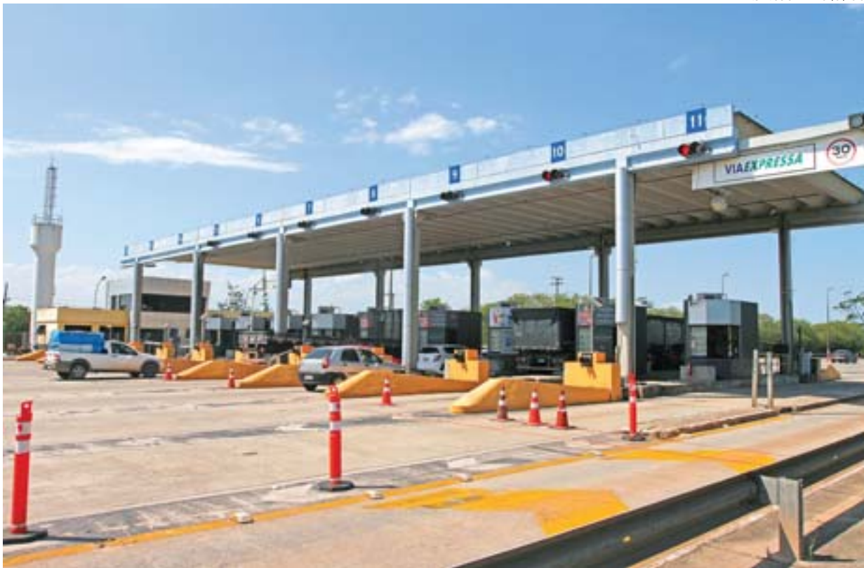
RODOVIA DO SOL, EM GUARAPARI: pedágio havia sido reduzido por falta de obras para conservação das pistas
