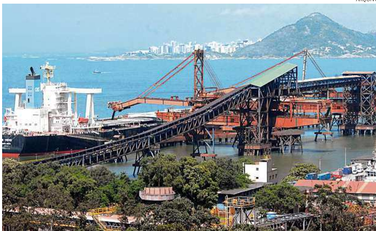
Acúmulo de minério de ferro em correias e plataformas da Vale provocou o derramamento no mar, diz relatório
