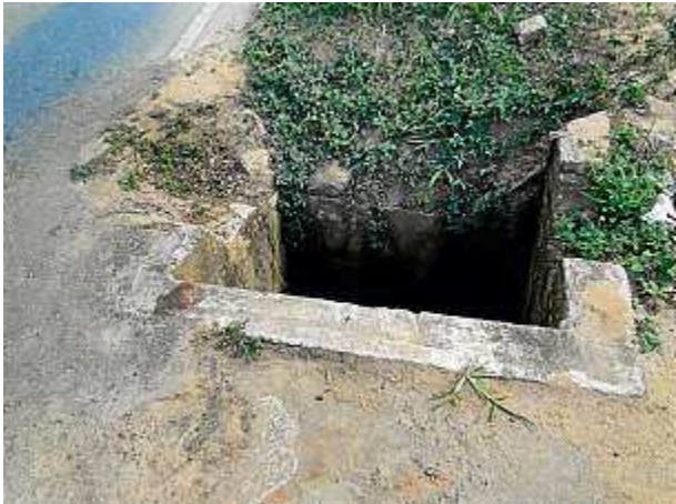
Bueiro fica perto da Segunda Ponte de Colatina
