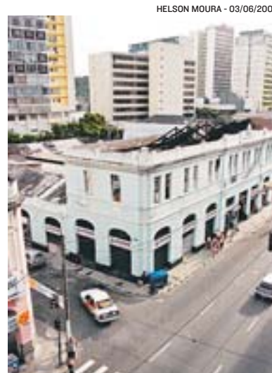
PRÉDIO após incêndio em 2002
