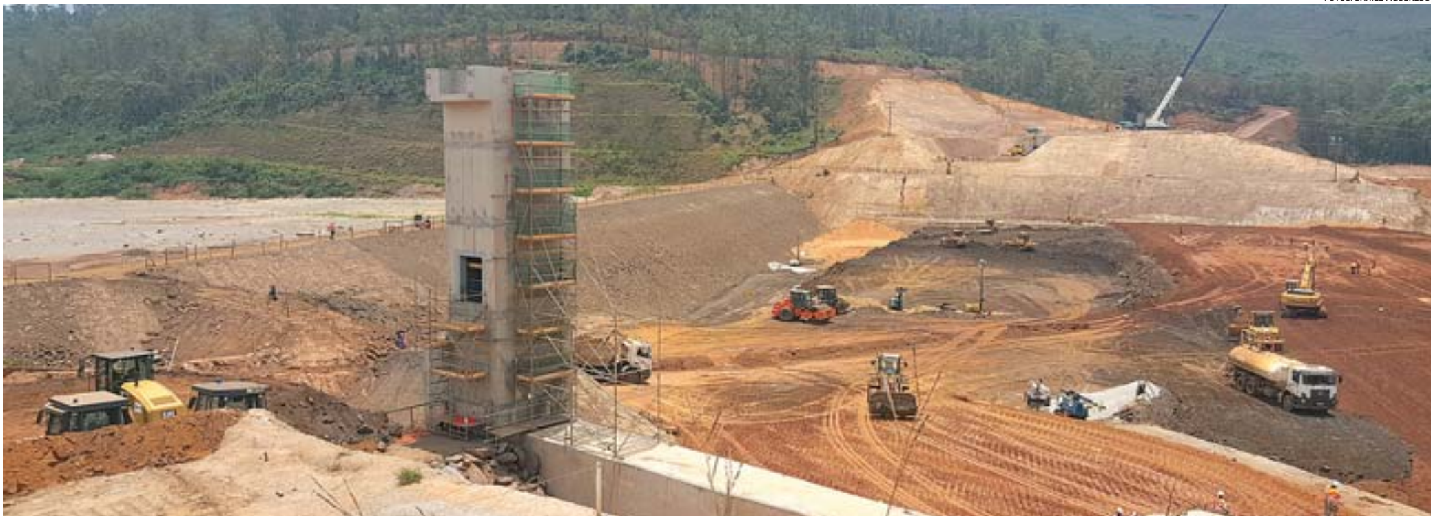
OBRA DE DIQUE EM SANTARÉM está sendo feita para conter os rejeitos de mineração e evitar que eles voltem a atingir a calha do Rio Doce, como ocorreu após rompimento de barragem
