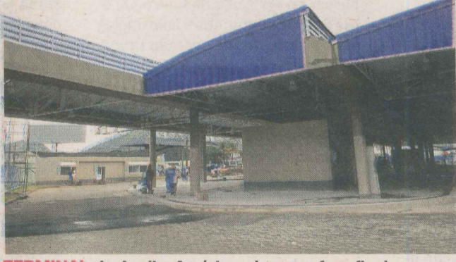
TERMINAL de Jardim América: obras em fase final
