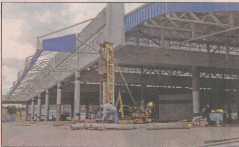
Obras em São Torquato, que terá novo terminal em março
