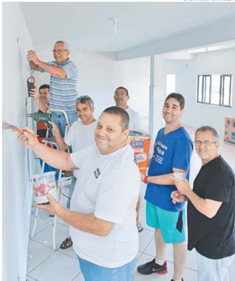
MORADORES fazem pintura nas paredes que ficaram danificadas
