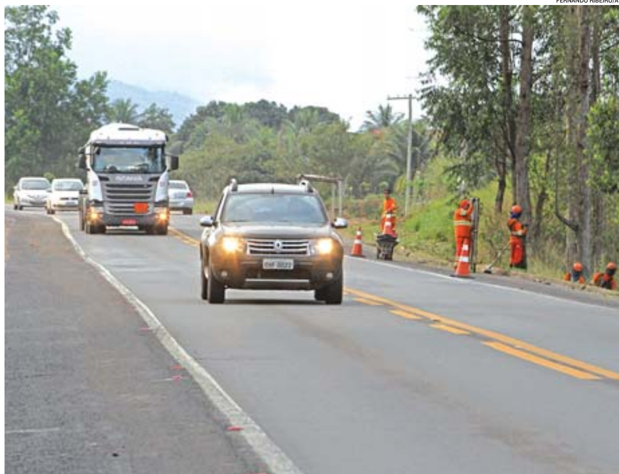
BR-101 NORTE: concessionária diz que está fazendo obras de recuperação da rodovia e melhorias no pavimento
