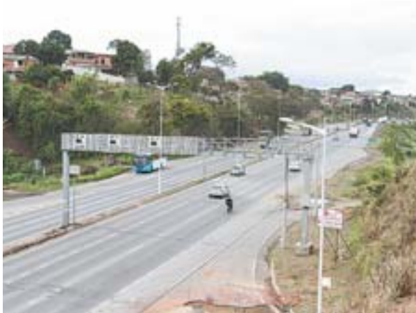
RODOVIA DO CONTORNO recebeu novas lâmpadas, de vapor metálico, no trecho de Cariacica, e vai ter iluminação reforçada também no trecho da Serra
