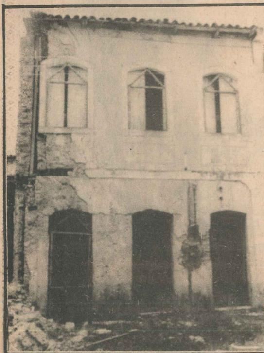
Nesta casa a parede estava demolida, pondo em risco o desabamento do telhado. Toda lateral foi reconstruída com os mesmos tijolos e alguns retirados da casa de nº 26
