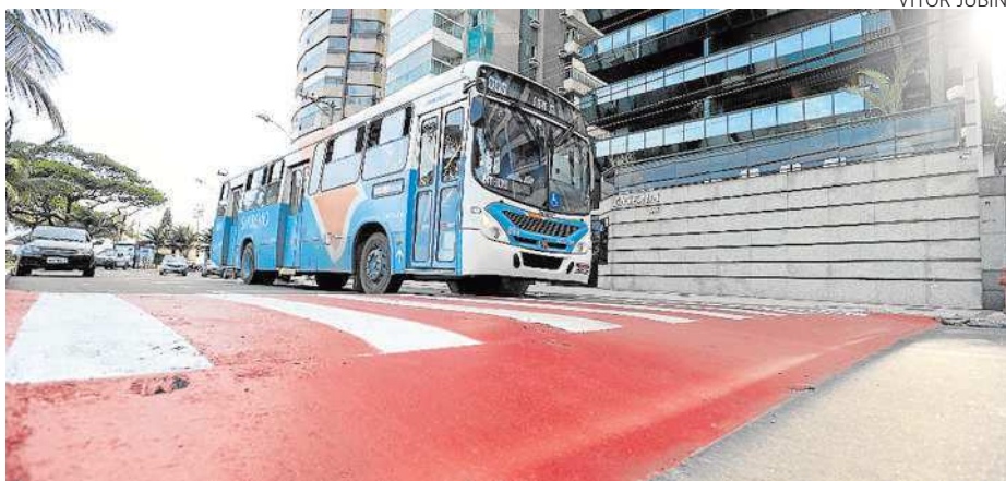
A faixa de pedestres foi construída na Avenida Antônio Gil Veloso, na Praia da Costa
