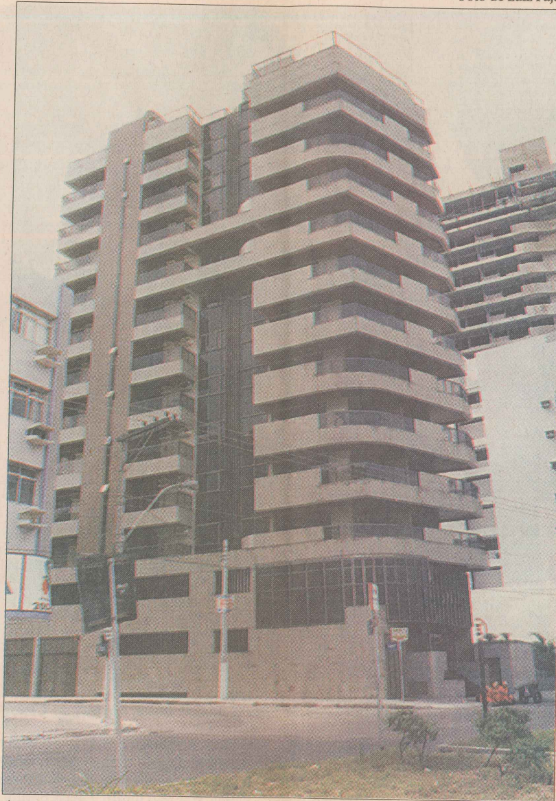
A construtora GM não respeitou o afastamento de três metros de cada via
