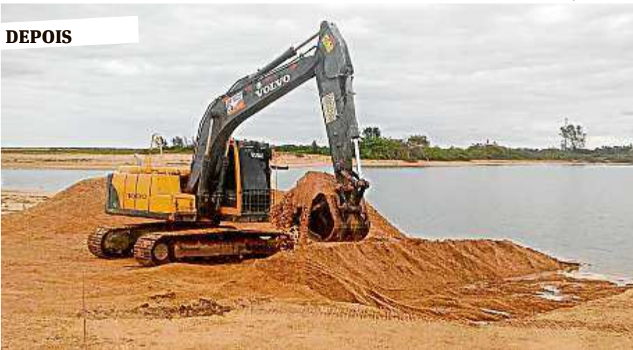
O canal que está sendo aberto terá 100 metros de comprimento e 1,5 m de largura
