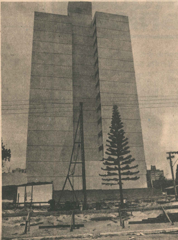
Na rua Afonso Cláudio o bate-estaca sem licenciamento
