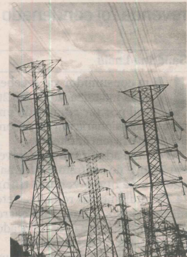
TORRE de energia: fraude
