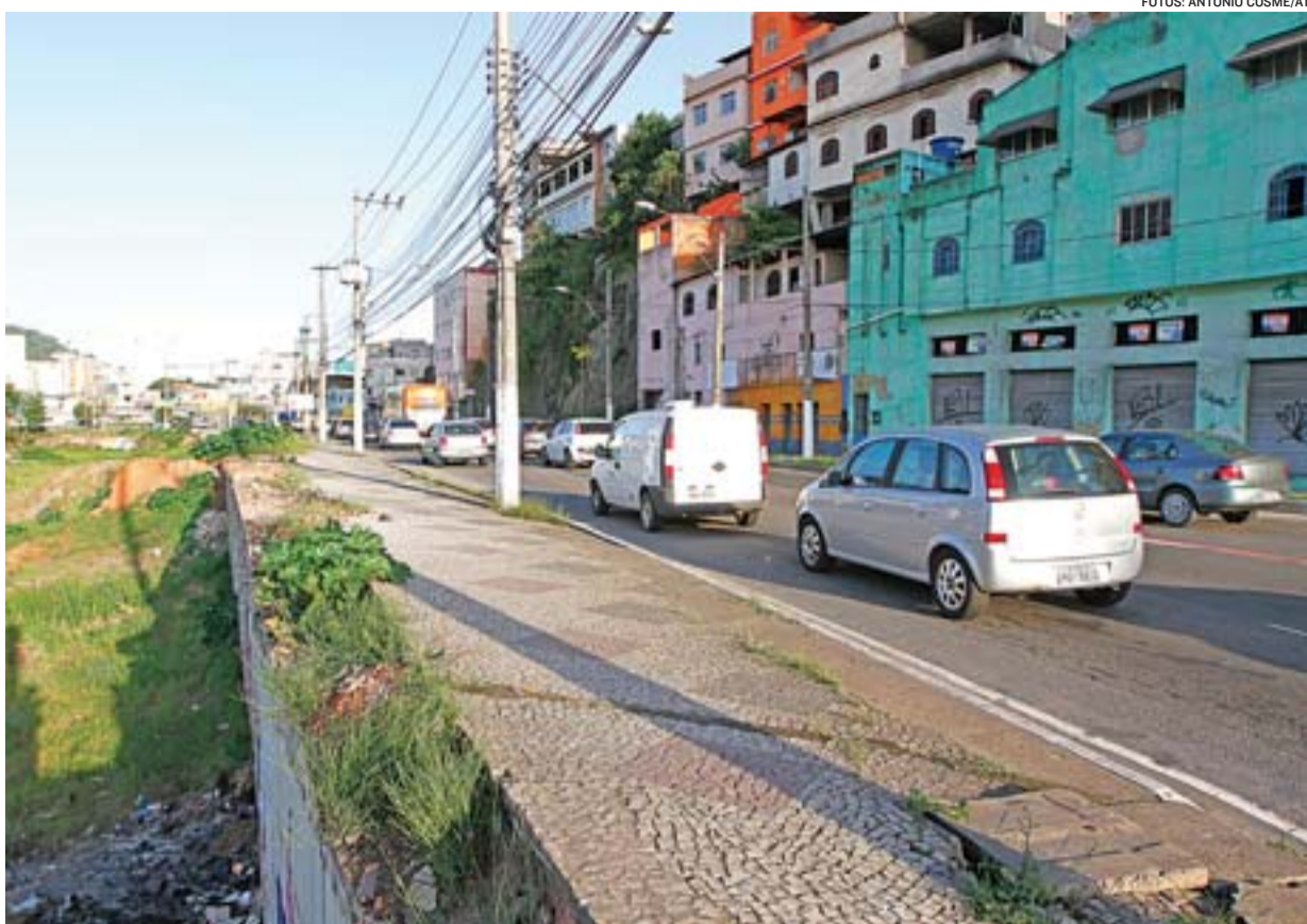
REGIÃO onde será construído viaduto do Portal do Príncipe para facilitar acesso à Rodoviária e ao Porto de Vitória
