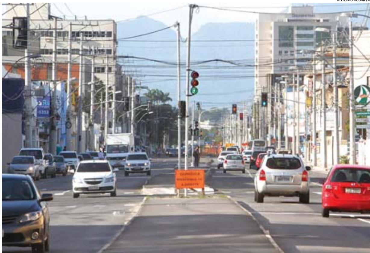
TRECHO DA AVENIDA Leitão da Silva que passa por intervenções: prazo inicial era de conclusão da obra em 2015
