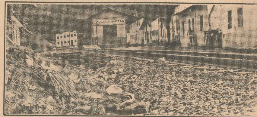
Com os canais pluviais entupidos, o lixo se acumula
