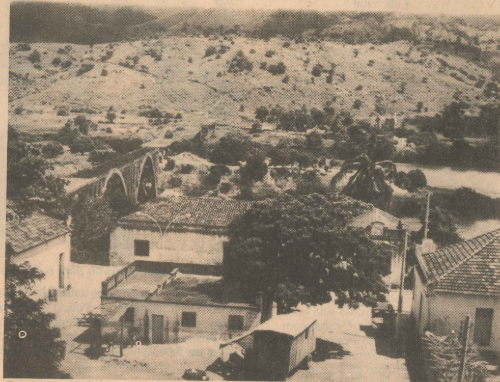
Itapina está há mais de 20 anos esperando que as obras da ponte sejam concluídas
