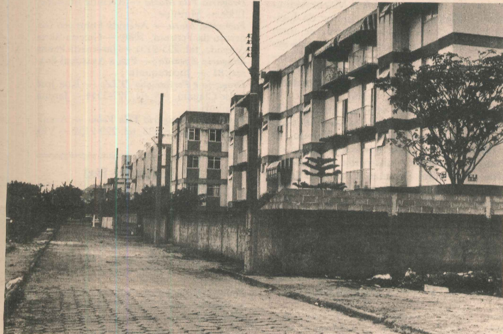
Moradores temem desvalorização de imóveis em edifícios com quatro andares
